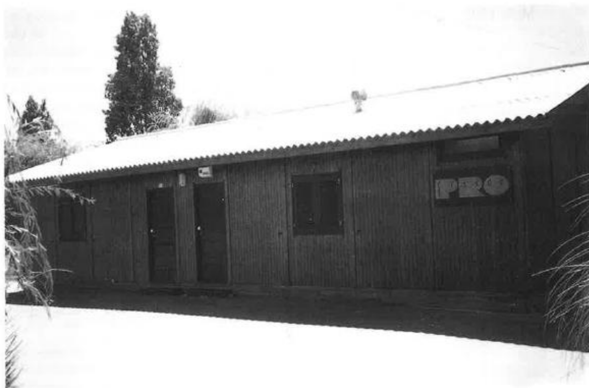
Pavilhão – aspecto exterior
